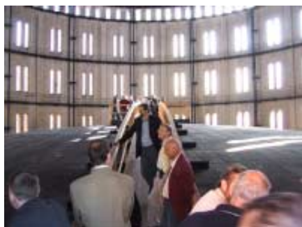
Inne i den gamla gasklockan. Nyttig volym 200000m3, Kolvens slaglängd 81 m, Kolvbelastning 737 t
